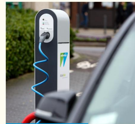
Installation borne de recharge électrique
