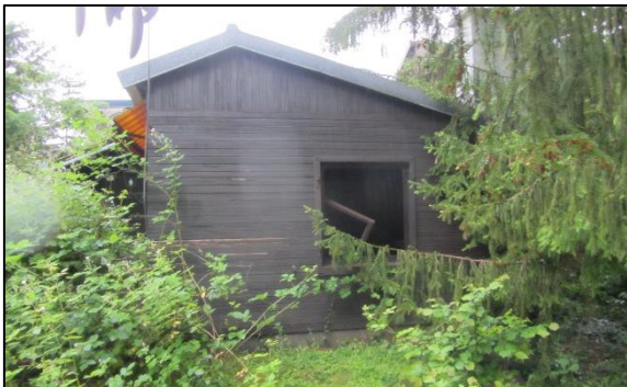
Abb. 2.10-4: Verlassene Hütte im Nadelbaumbestand im Süden der Fläche.
