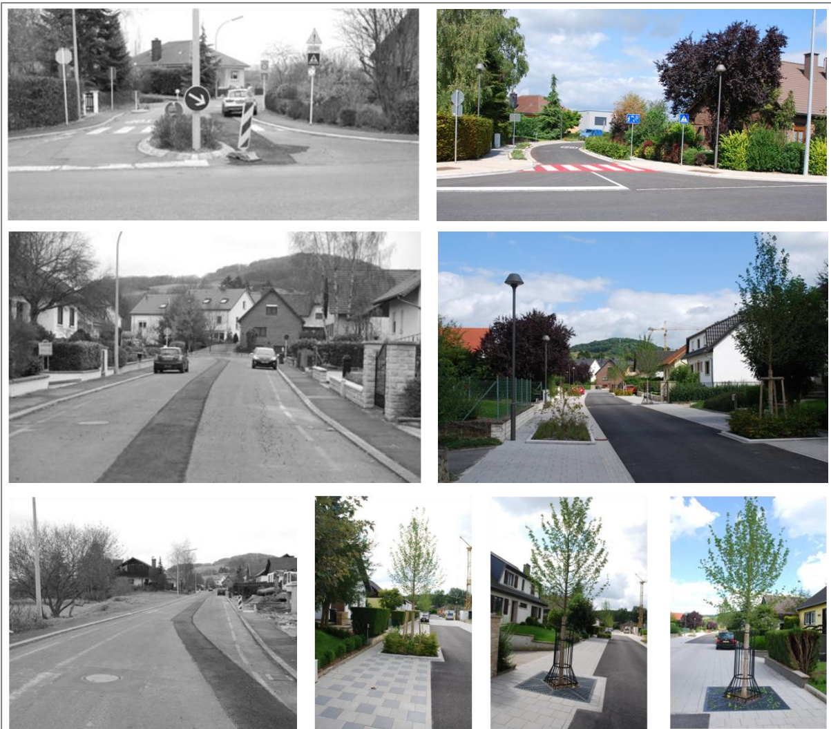
Bsp.: Umgestaltung einer Wohnstraße als „zone de rencontre“ in Uebersyren (Vorher/Nachher), CO3 2013-2014.
