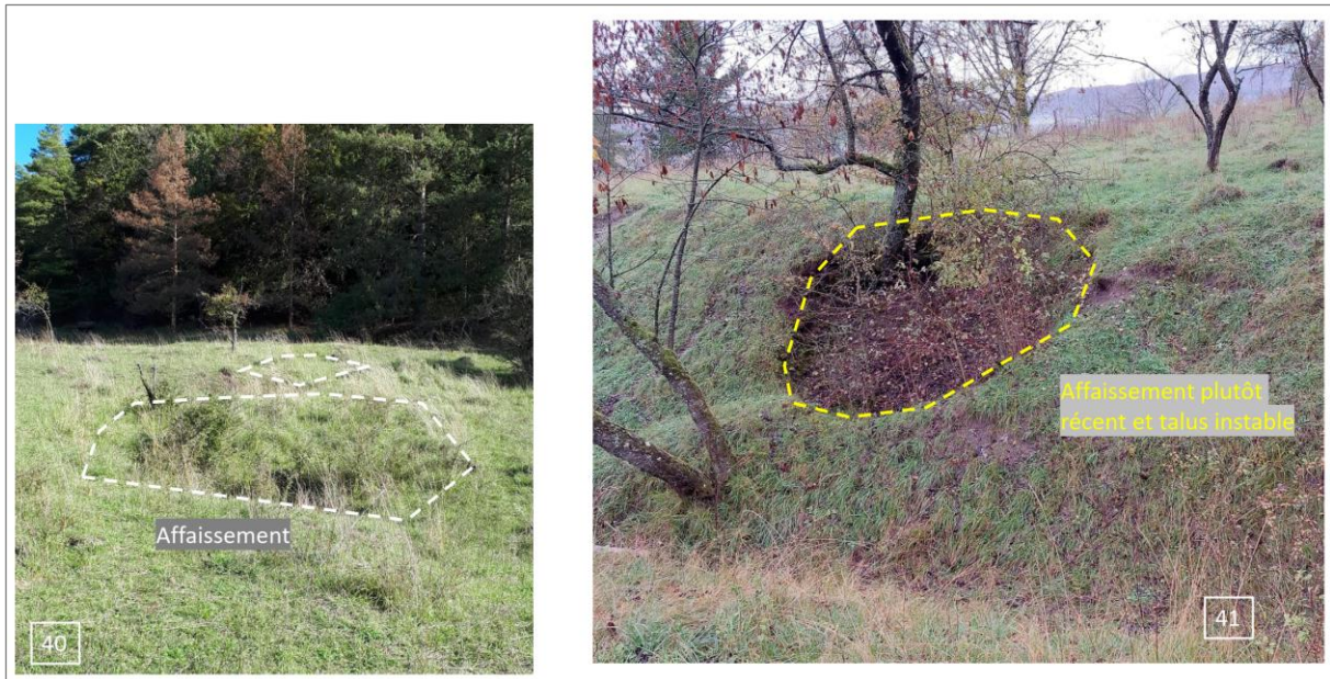
Abbildung 11: Anzeichen für Senkungen im Bereich des ehemaligen Gipsbergwerk. Quelle: Géoconseils 2022
