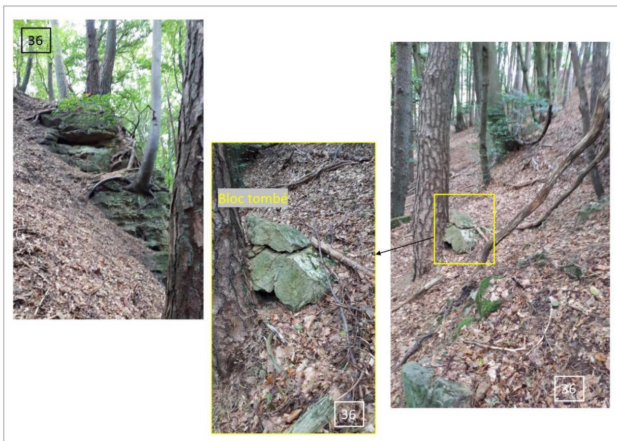
Abbildung 8: Abbruchkanten und stumme Zeugen vergangener Sturzereignisse östlich von Helmsange. Quelle: Géoconseils 2022
