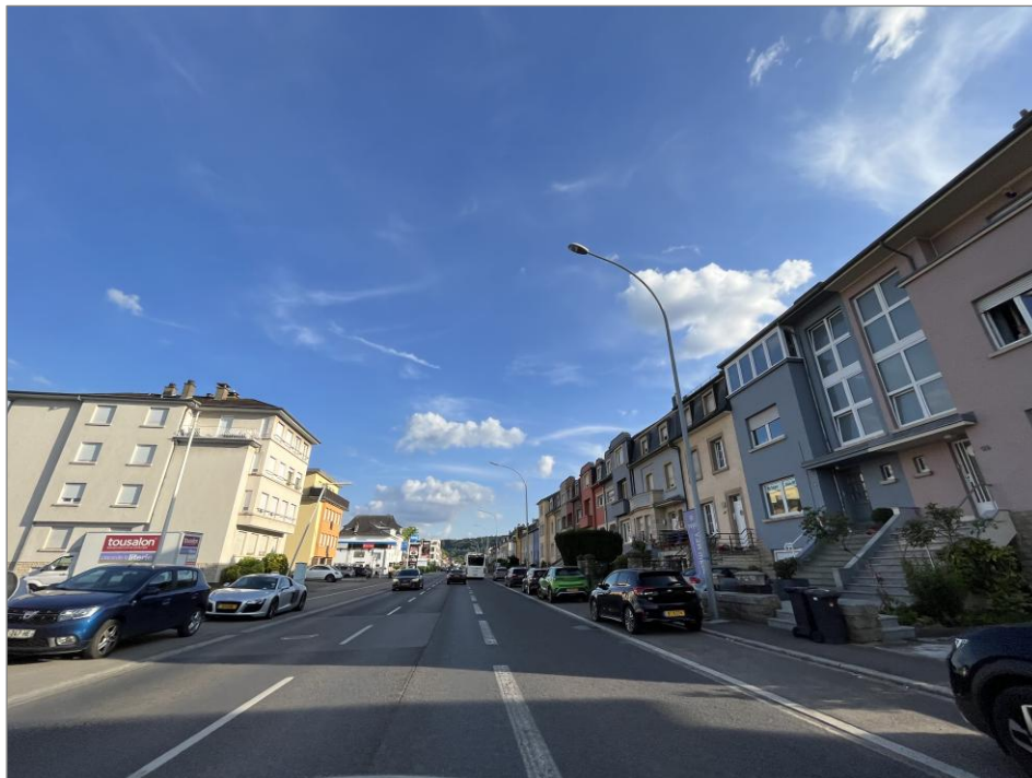
Abbildung 67: Schlechte Aufenthaltsqualität und MIV-Dominanz an der N7 in Bereldange. Quelle: Cyclomedia April 2022
