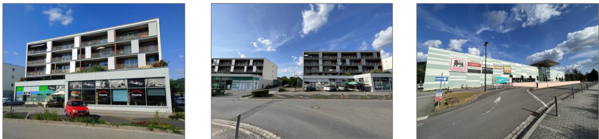
Abbildung 29: gewerbliche Sockelzonen in der Rue des Romains (links und mittig) & Delhaize Helmsange (rechts). Quelle: CO3 2021 & 2023
