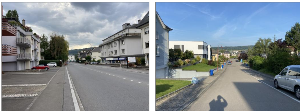
Abbildung 69: Schlechte Aufenthaltsqualität, wenig bis keine Straßenbegrünung und überdimensionierte Straßenräume im Verhältnis zur Wohnfunktion. Am Becheler Bereldange (links), Rue des Sources Walferdange (rechts). Quelle: CO3 2021
