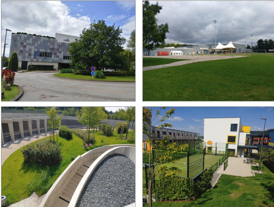
Abbildung 52: Rezente Sonderbauwerke: PIDAL in Helmsange (links oben), Multisportkomplex Prince-Henri in Helmsange (rechts oben), Unterführung der Bahngleise in Walferdange (links unten), Vergrößerung der Schule in Helmsange (rechts unten).
