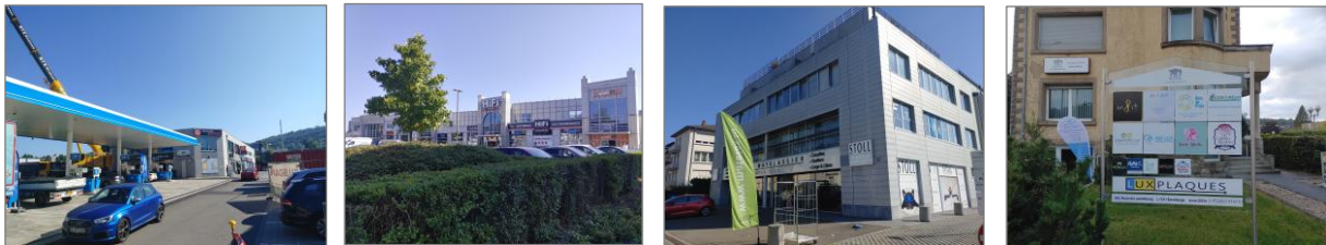
Abbildung 25: verschiedene Versorgungs- und Dienstleistungsbetriebe am N7 Band Bereldange. Quelle: CO3 2021
