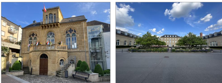
Abbildung 49: Sonderbauwerke: Dufainghaus in Walferdange und Schlosskomplex in Helmsange. Quelle: CO3 2023
