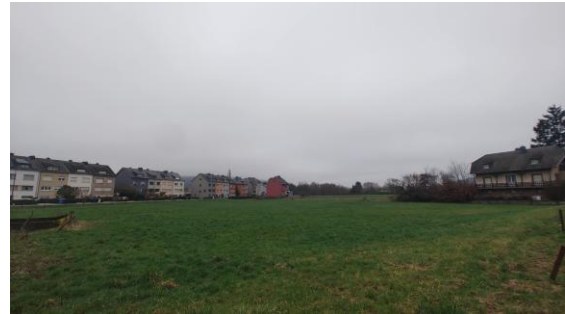
Abbildung 3: Blick nach Norden auf das Plangebiet
