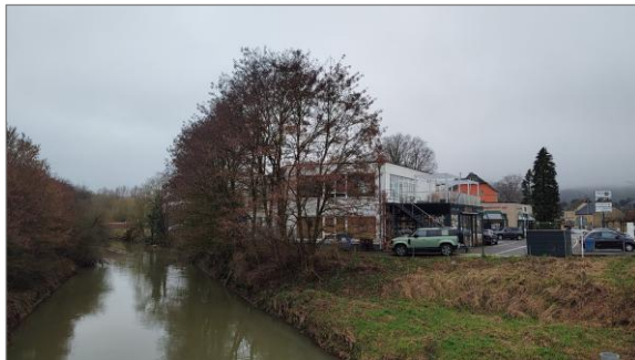
Abbildung 1: Blick von Alzette-Brücke im Verlauf der „Route de Luxembourg“ auf das Plangebiet in südlicher Richtung
