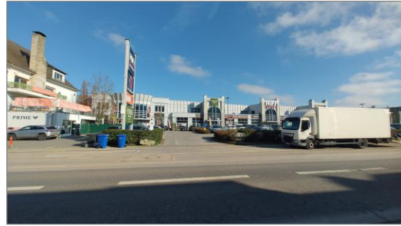
Abbildung 2: Blick von der „Route de Luxembourg“ in Richtung Osten auf das Plangebiet
