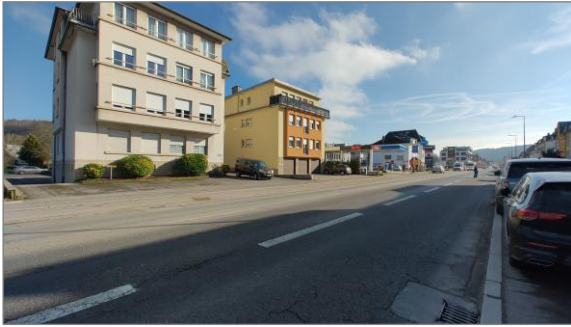
Abbildung 1: Blick von der „Route de Luxembourg“ in Richtung Südosten auf das Plangebiet
