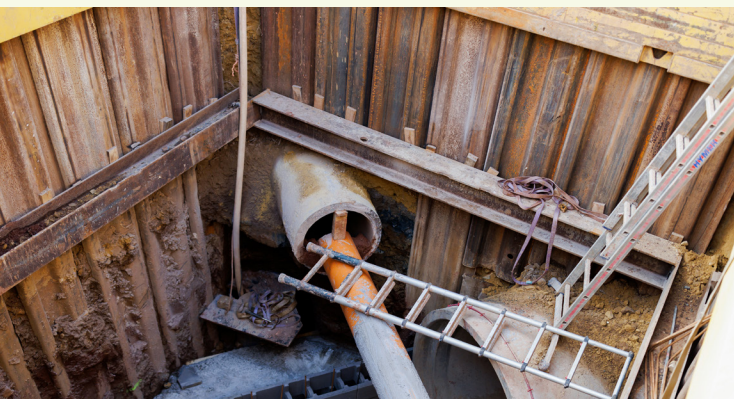
Chantier RÜB bei der Pidal
