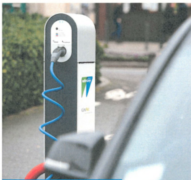
Installation borne de recharge électrique
