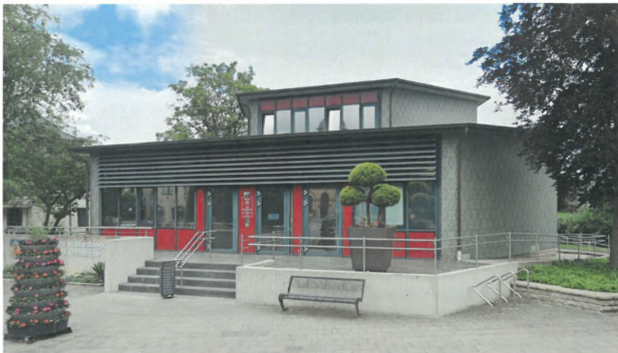
Figure 19 : Enveloppe thermique - Département technique
