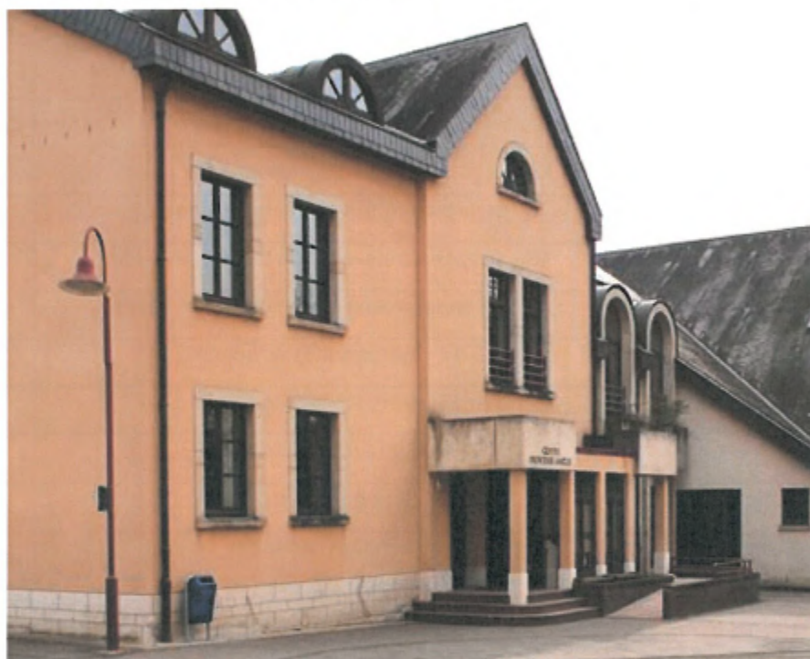
Figure 35 : Vue façade - Centre Princesse Amélie
