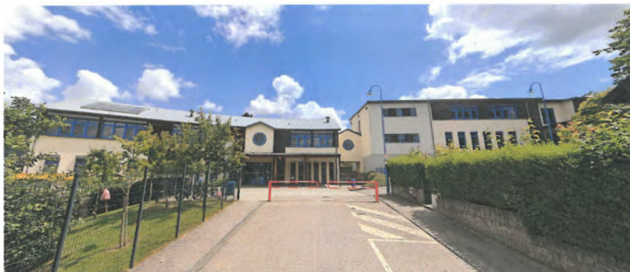
Figure 27 : Vue façade - Ecole de Helmsange
