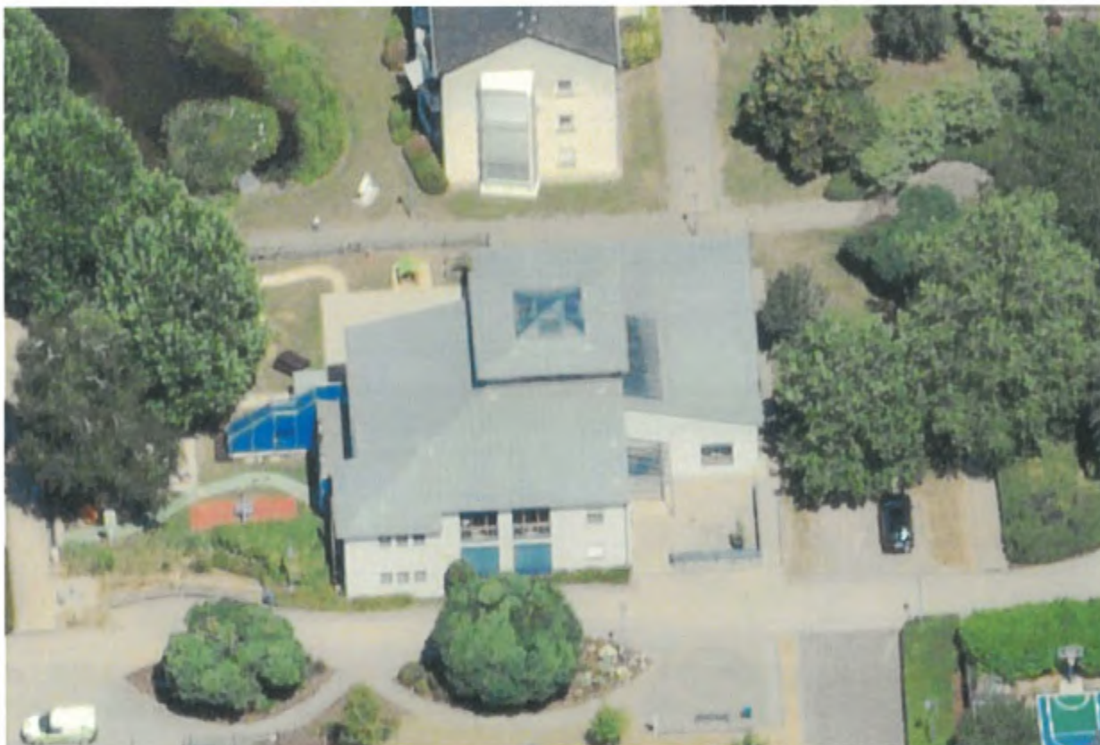
Figure 37 : Vue façade – Crèche Beienhaischen
