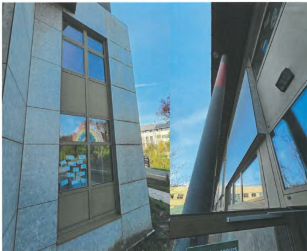
Figure 33 : Vue façade – École de Walferdange
