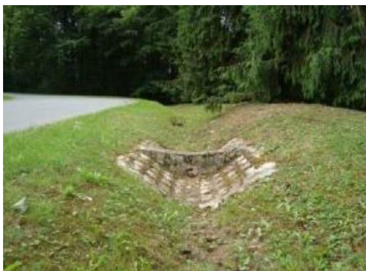
Figure 24: Exemple d'aménagement de fossé en cascades
