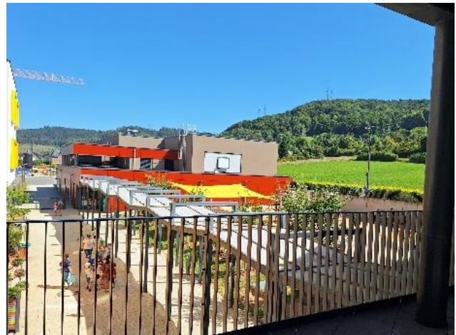
Blick von Süden auf den nördlichen Hof
