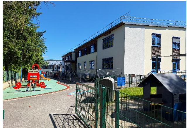
Blick von Süden auf den südlichen Schulhof
