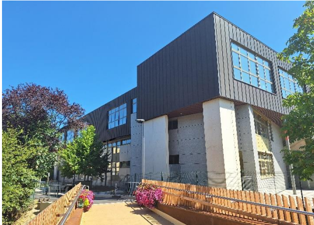
Südwestfassade des Bildungsgebäudes
