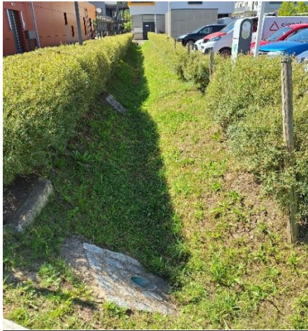
Rigole am nördlichen Gebäude
