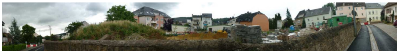
Figure 1: Vue sur l'îlot central depuis le site PAP
