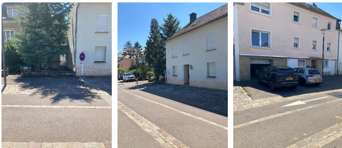
Figure 9 : Bâtiments existants dans le périmètre du PAP (Source : BEST)
